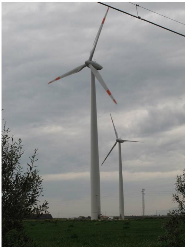
FOTO 1 – due macchine eoliche da 900 KW (0,9 MW) in agro di Foggia (si noti il mezzo alla base). Si eludono così le flebili norme realizzando 2 macchine sotto soglia di 1 MW, con semplice comunicazione edilizia semplificata (DIA, poi PAS) invece di 1 macchina da 2 MW assoggettata a VIA e Autorizzazione unica
